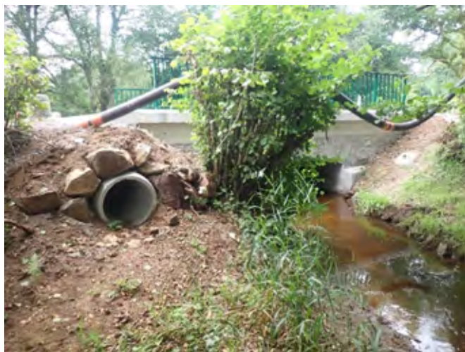
Figure 2 : Buse sèche en béton, Planchez (58) (©Justine Colinet)
